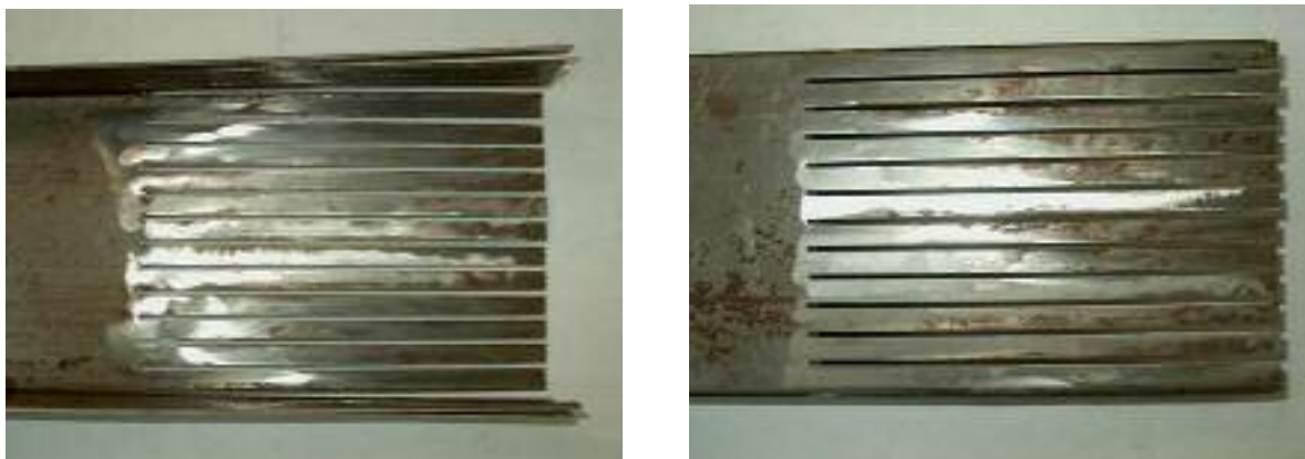
Figura 124: Floare reziduală – vedere inimă (față și spate)
