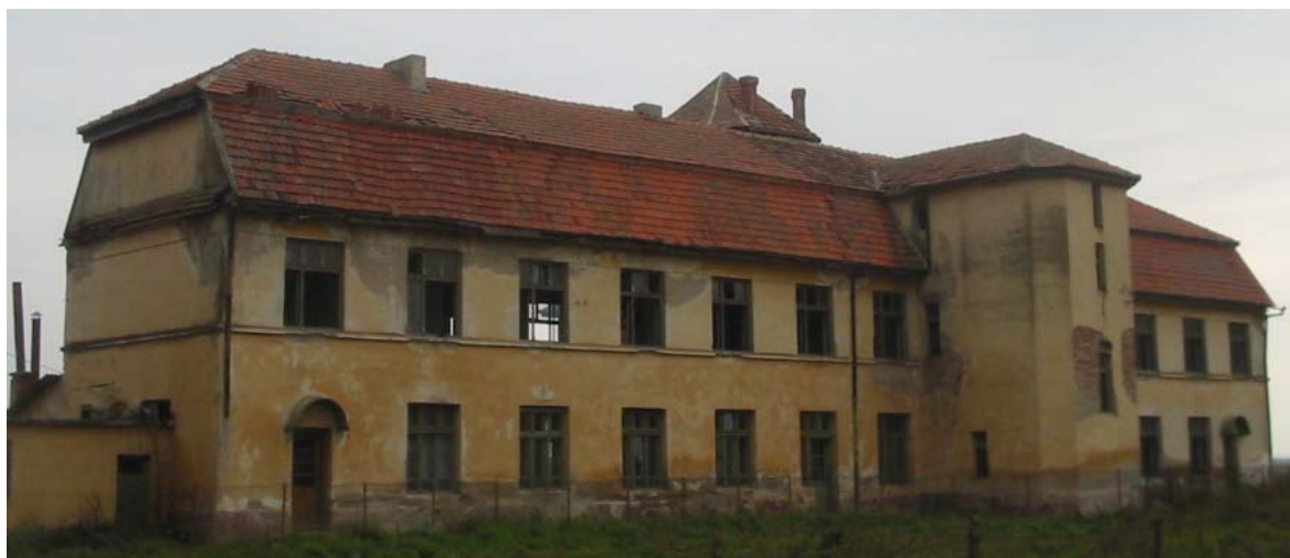
Foto 5.1 – Vedere a clădirii expertizate
