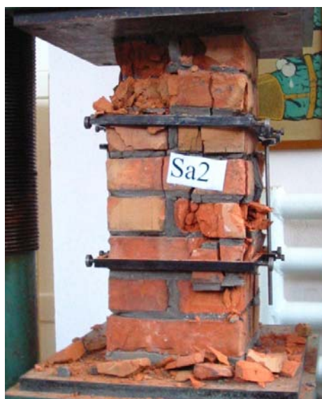
Foto 3.18 – Ruperea unui stâlpișor de zidărie armată
