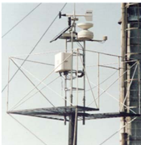
Figura 1: Statia meteo CR –10 instalata la Padurea Verde.
