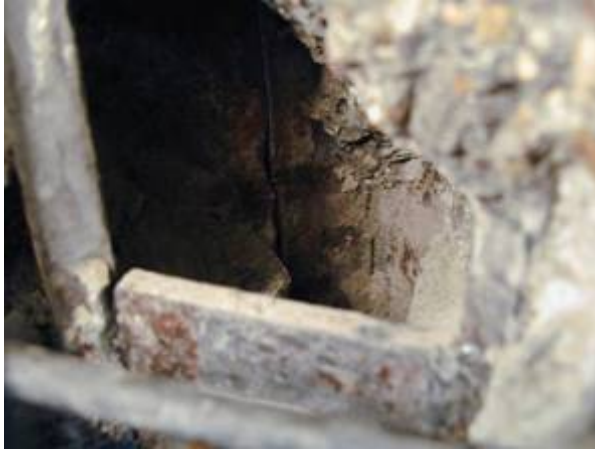
Foto 3 – Fisurarea în dreptul sudurii a rigidizării Verticale dintre tălpile stâlpului
