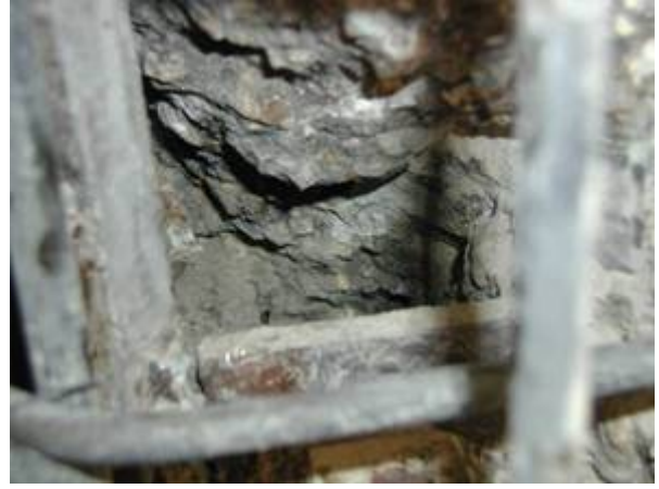
Foto 4 - Elementul experimental CJ2 – dezvoltarea fisurilor -
