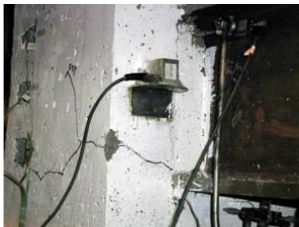
Foto 2 - Elementul experimental CJ2 – dezvoltarea fisurilor -
