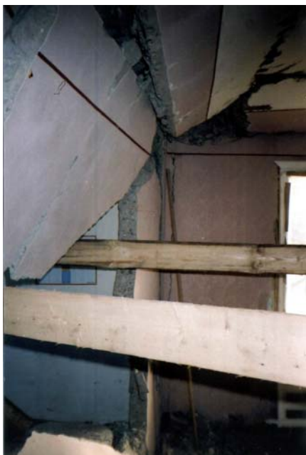
Figura 14. Dislocarea panourilor verticale.
