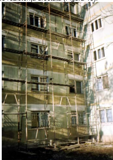
Figura 13. Bloc de garsoniere din panouri mari prefabricate.
