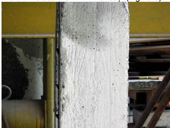
Figura 8. Desprinderea lamelelor verticale CFRP datorită eforturilor de compresiune
