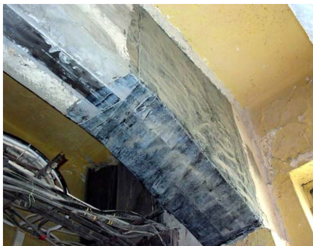
Figura 12b. Consolidarea grinzilor cu lamele și țesături din fibra de carbon.
