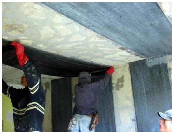
Figura 17. Consolidarea panourilor orizontale.
