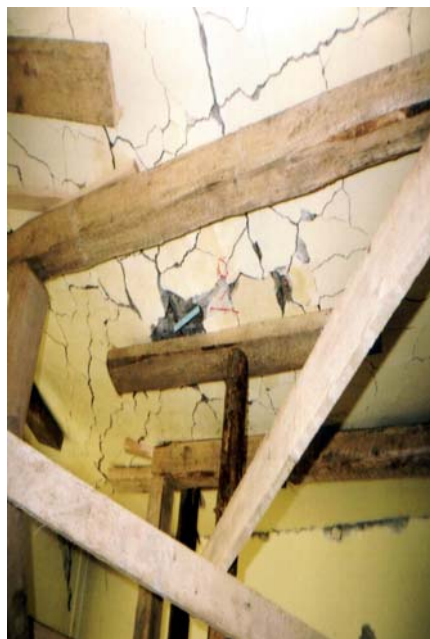
Figura 15. Fisurarea panourilor orizontale.
