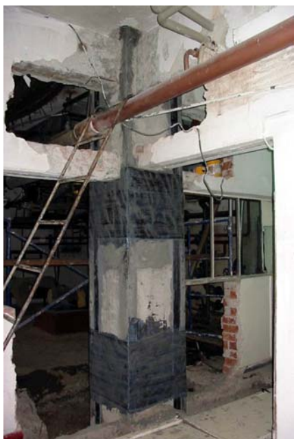
Figura 12a. Consolidarea stâlpului cu lamele și țesături din fibra de carbon.
